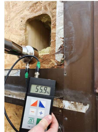
sondages sur les façades effectués en 2022 par un ingénieur spécialisé
