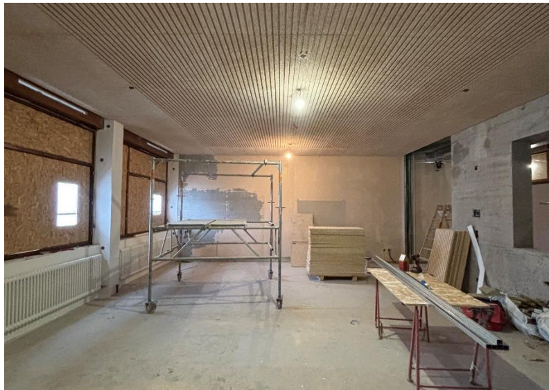
@ Transphère Consult SA - Vue d'une salle de classe en travaux et du mur parasismique
