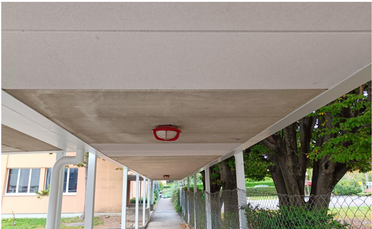
Les plaques vieillissent et doivent être remplacée. (Les blanches sont déjà neuves)
