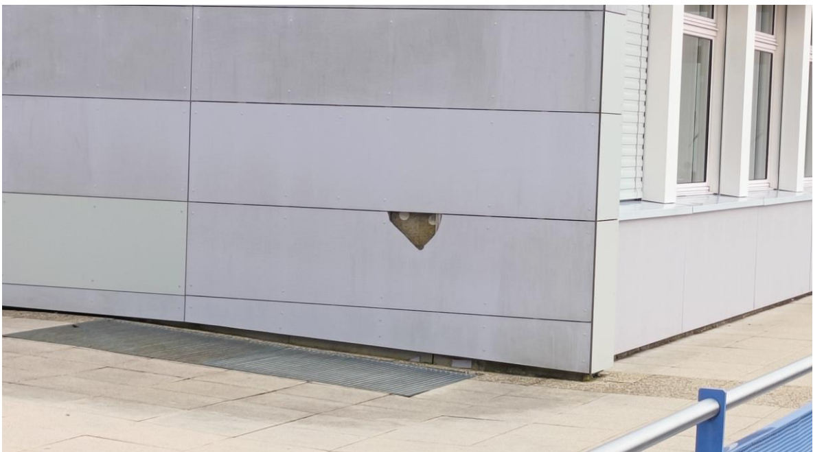
Les plaques d'origines sont fragiles et remplacées par du solide au fur et à mesure des déprédations.
