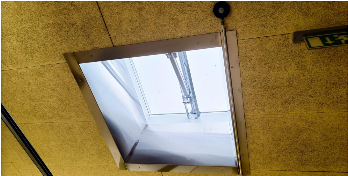
Evacuation des fumées sur le toit
