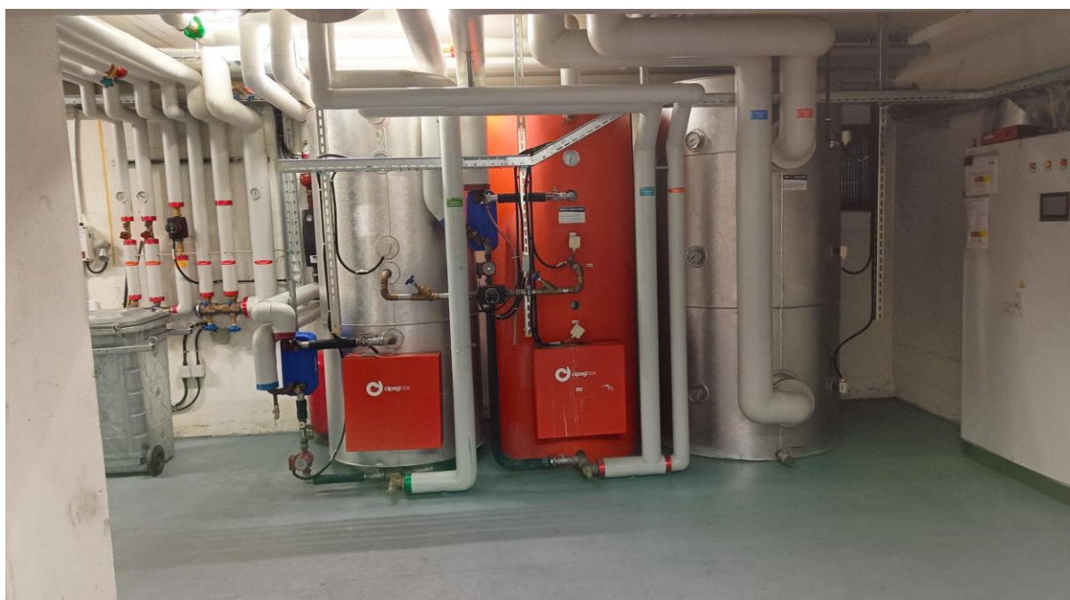
Le système de chauffage par pellets.
