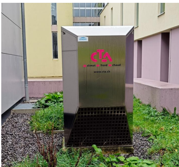
La pompe à chaleur installée à l'extérieur
