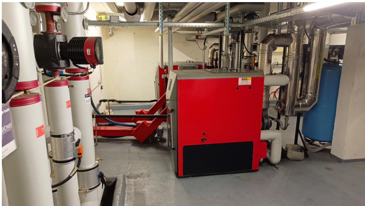
Le système de chauffage par pellets.
