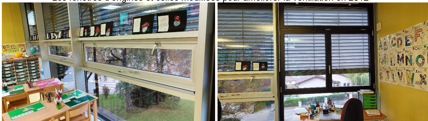
Les fenêtres d'origines et celles modifiées pour améliorer la ventilation en 2012
